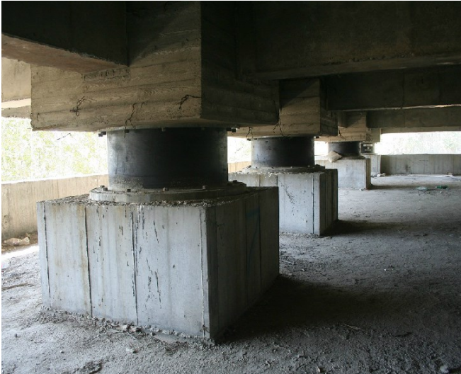
شکل ۱۱ جداگر و میراگر لرزه‌ای استفاده شده در پروژه مسکونی
