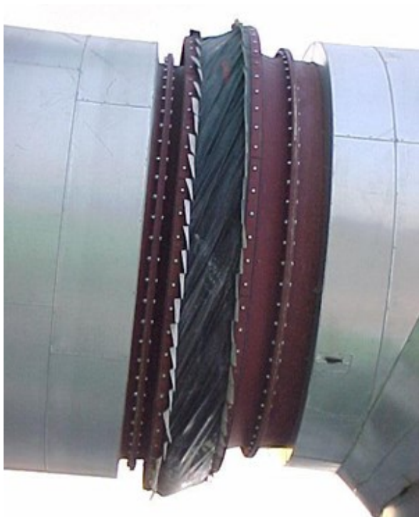
شکل ۱۶ اتصال پارچه‌ای
