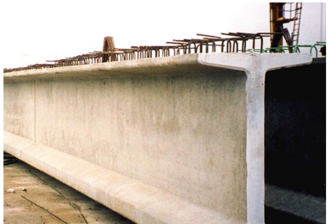
شکل ۲ استفاده از فولاد MMFX 2 در ساخت پل
